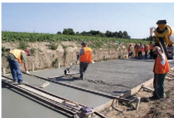
Rys. 6.2. Transport mieszanki i układanie nawierzchni w deskowaniu stałym
