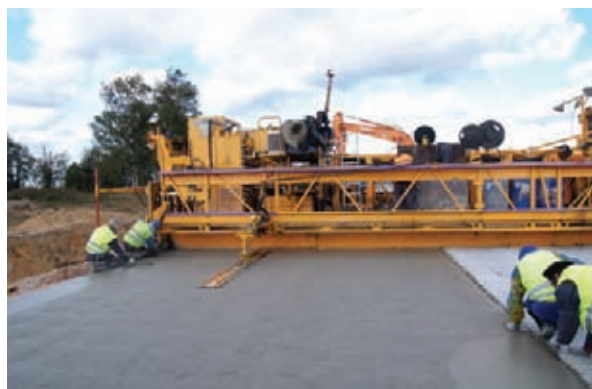
Rys. 6.1. Transport mieszanki i układanie nawierzchni w deskowaniu ślizgowym
